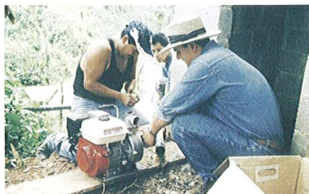
Instalando el motor que lleva agua hasta la escuela.
